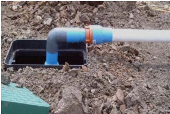
Caja de válvulas para hidrante
